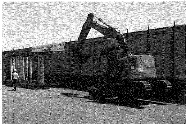
トリプルストロングウォールを引くとあまりの高強度に建設重機後方のキャタピラが浮き上がってしまった。 この後に81kNで破壊
